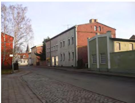
Abb. 6: Fehlende Wärmedämmung an den Giebeln
