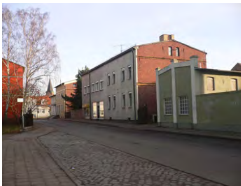
Abb. 6: Fehlende Wärmedämmung an den Giebeln
