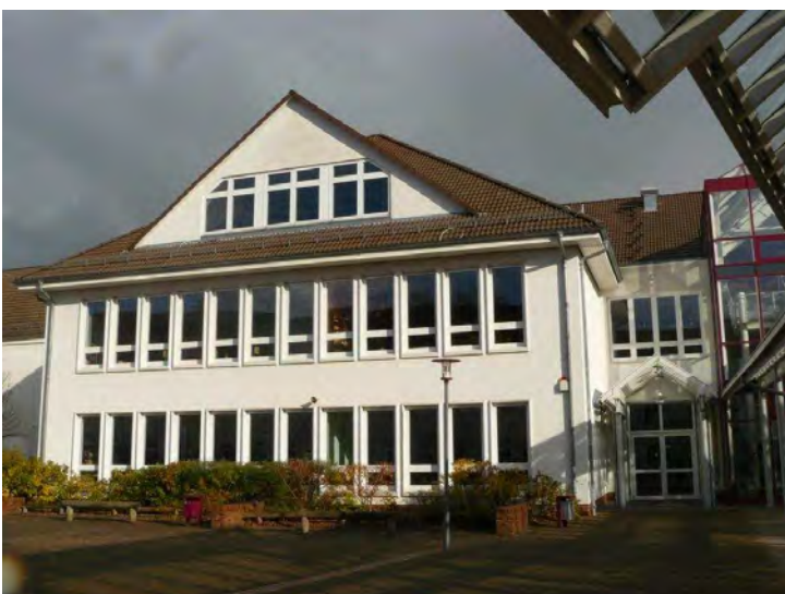
Abb. 13: Regionale Schule (Neubau)
