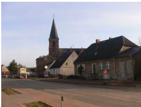
Abb. 5: Unsanierete Häuser an der Hauptstraße
