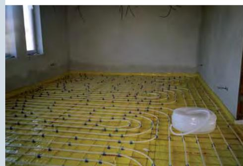
Die Verlegung der Rohre für die Fußbodenheizung
