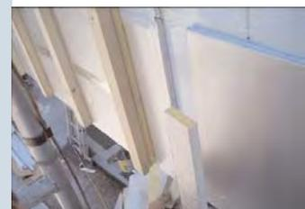
Die Vakuumisulationspaneele und das Passstück aus Polyurethan
