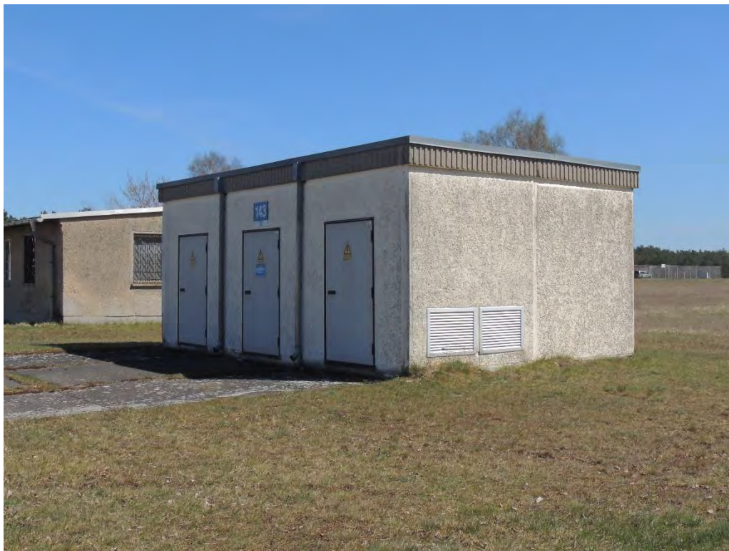
Bild 08 Trafo - potenzielle Fledermaus-Sommerquartiere unter Drempeblech
