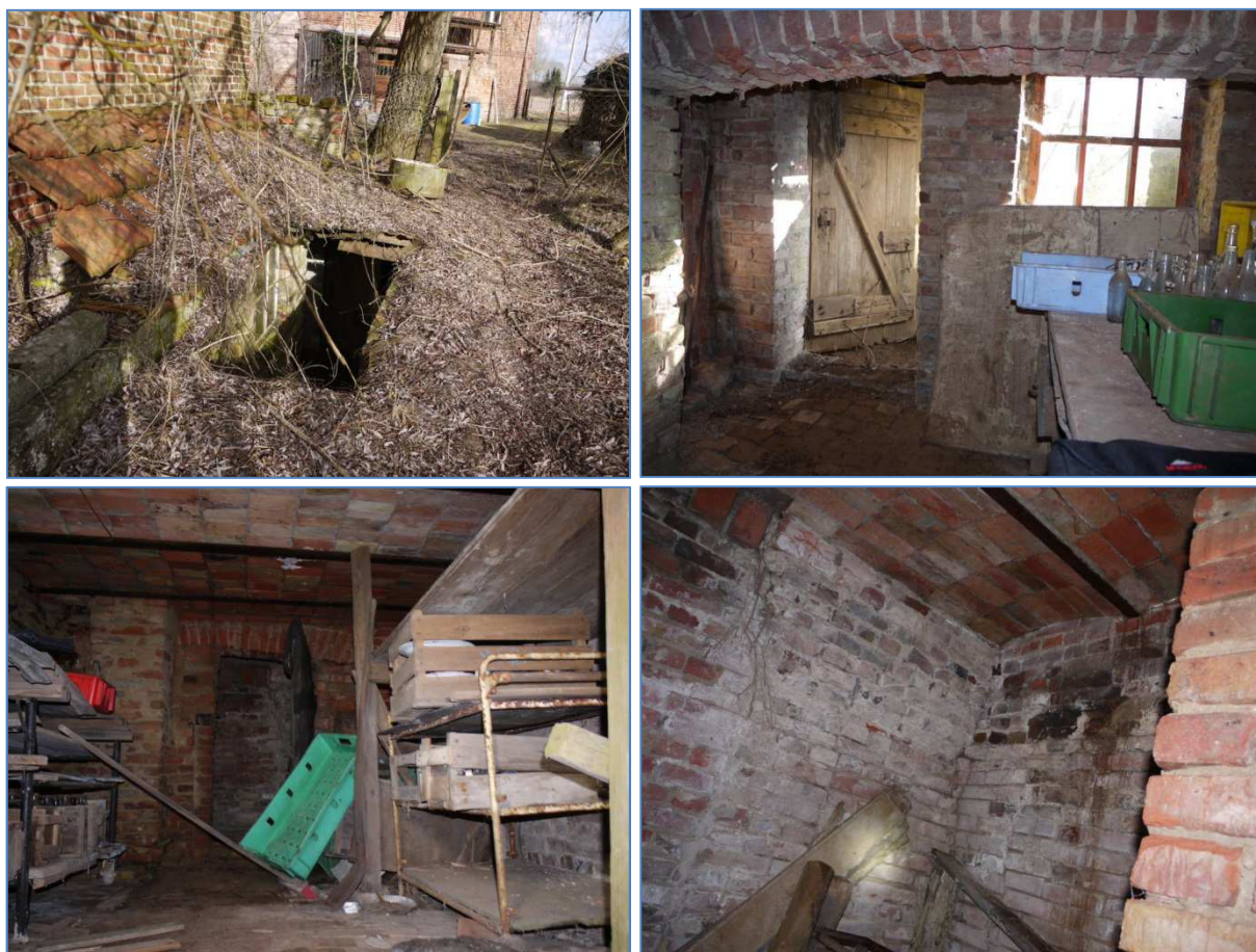
Abb. 15-18 Unterkellerung eines der Nebengebäude
