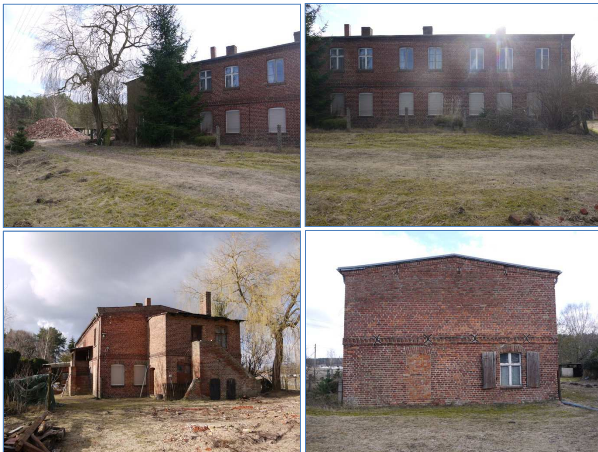
Abb. 3-6 Ansichten des bestehenden Wohngebäudes
