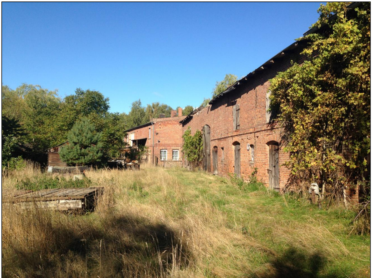
Abbildung 1: im Planungsraum bestehende Bausubstanz mit Scheune im Vordergrund und Wohnhaus, Baukonzept Neubrandenburg GmbH, Oktober 2015
