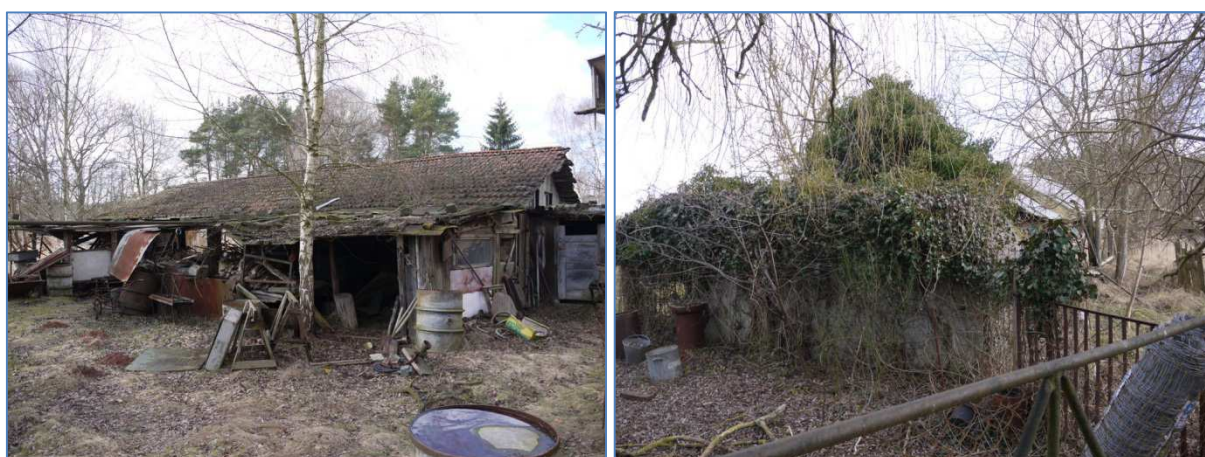
Abb. 7 und 8 Ansichten der Nebengebäude
