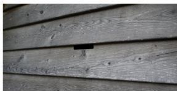
Stülpschalung mit Fledermaus-Kriechschlitz in der Fläche
