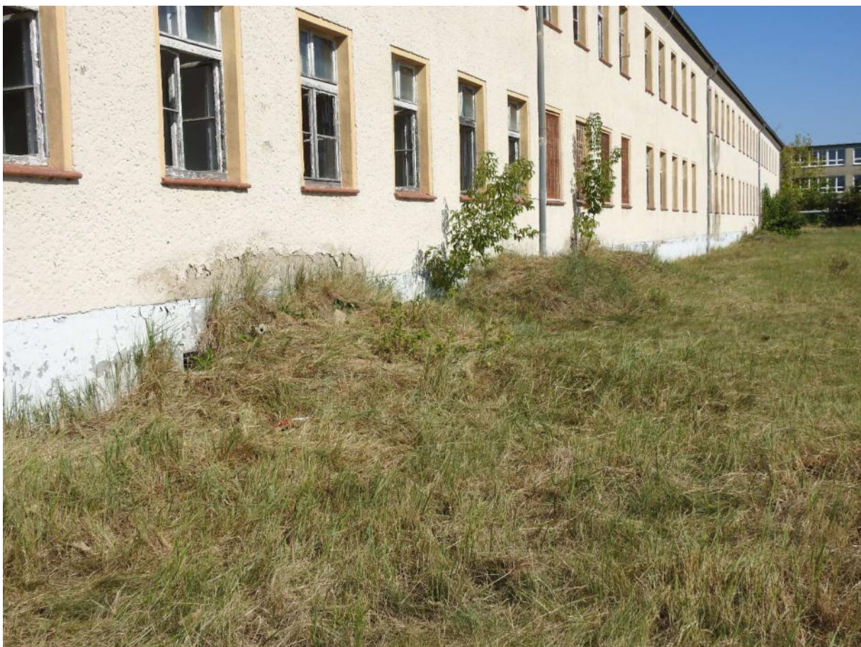
Abb.: Sehr gute Eiablage in Hügelstrukturen an südexponierter Mauer Kaserne (Nordteil)
