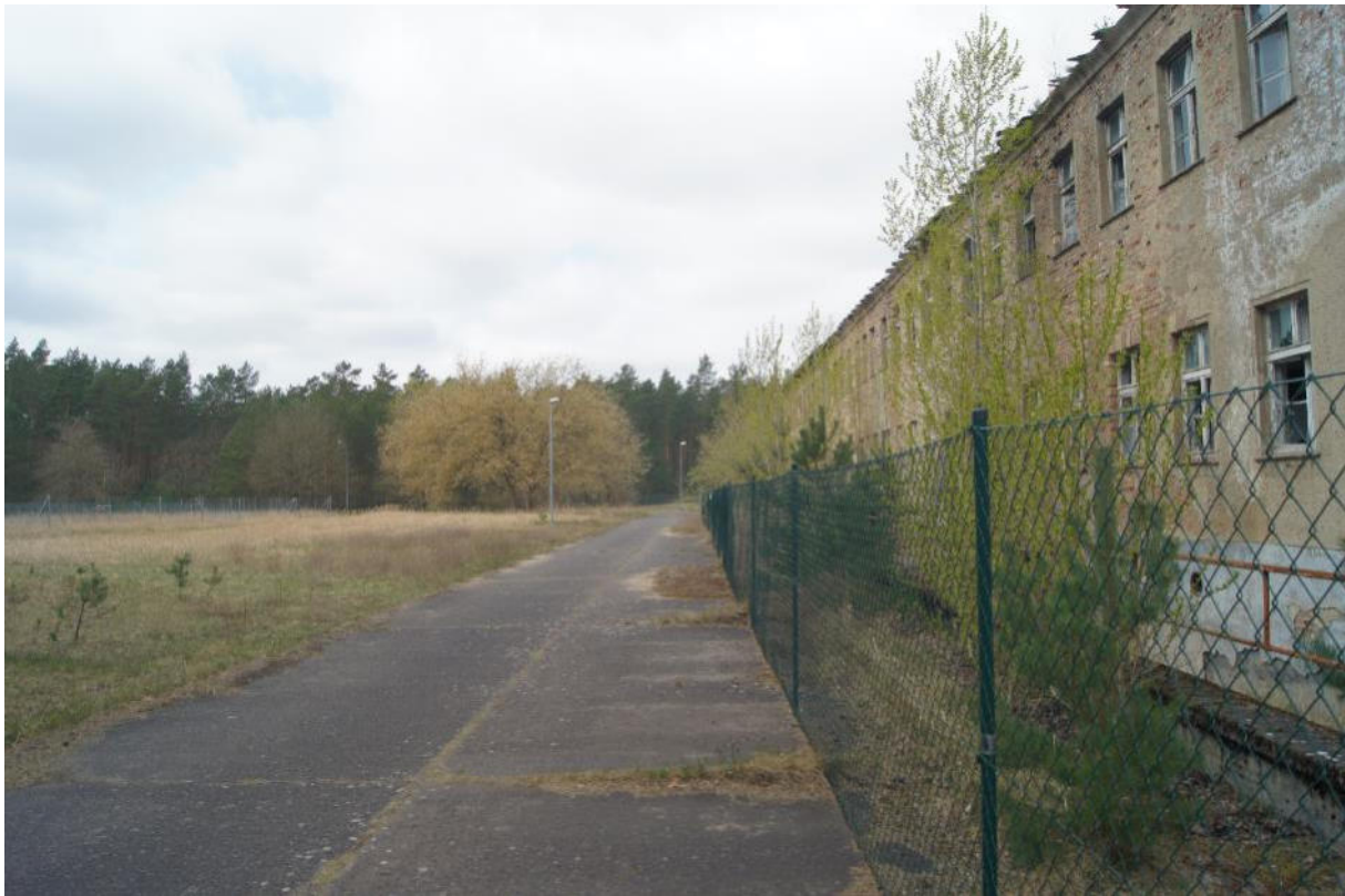
Bild 01 Waldabstandsflächen (M1) im Westen- PV rechts vom Zaun
