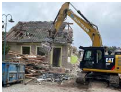
HAFF-TRANS übernimmt den Abriss und die Entsorgung von alten Schuppen, Garagen oder Häusern.
